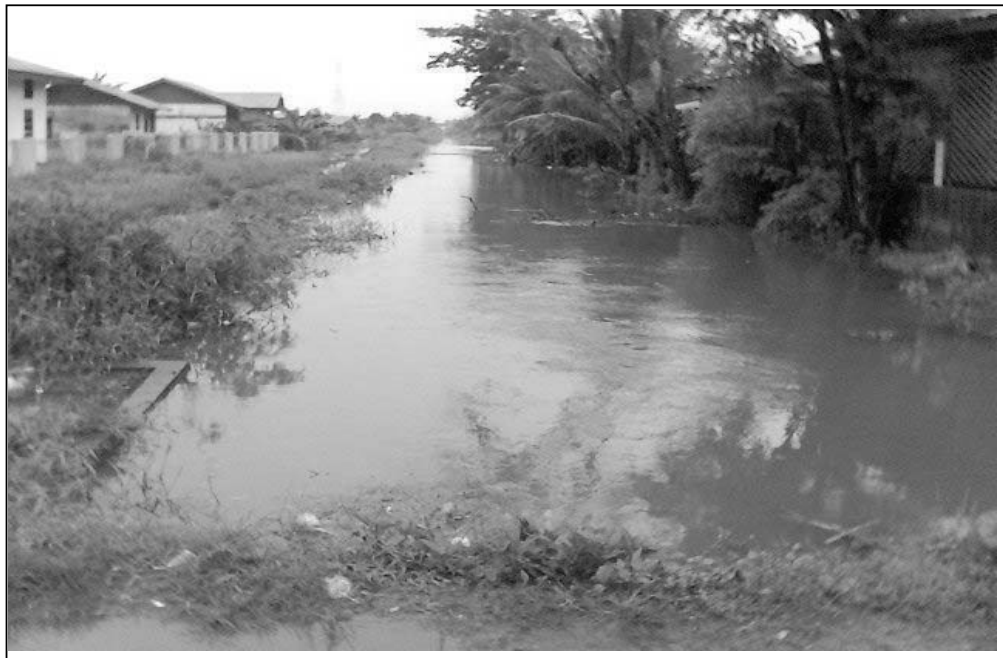
Gambar 3.15. Salah satu drainase yang setiap waktu meluap menggenangi pemukiman penduduk di sekitarnya saat pasang naik air laut. (Sumber DPU Merauke, 2006)
