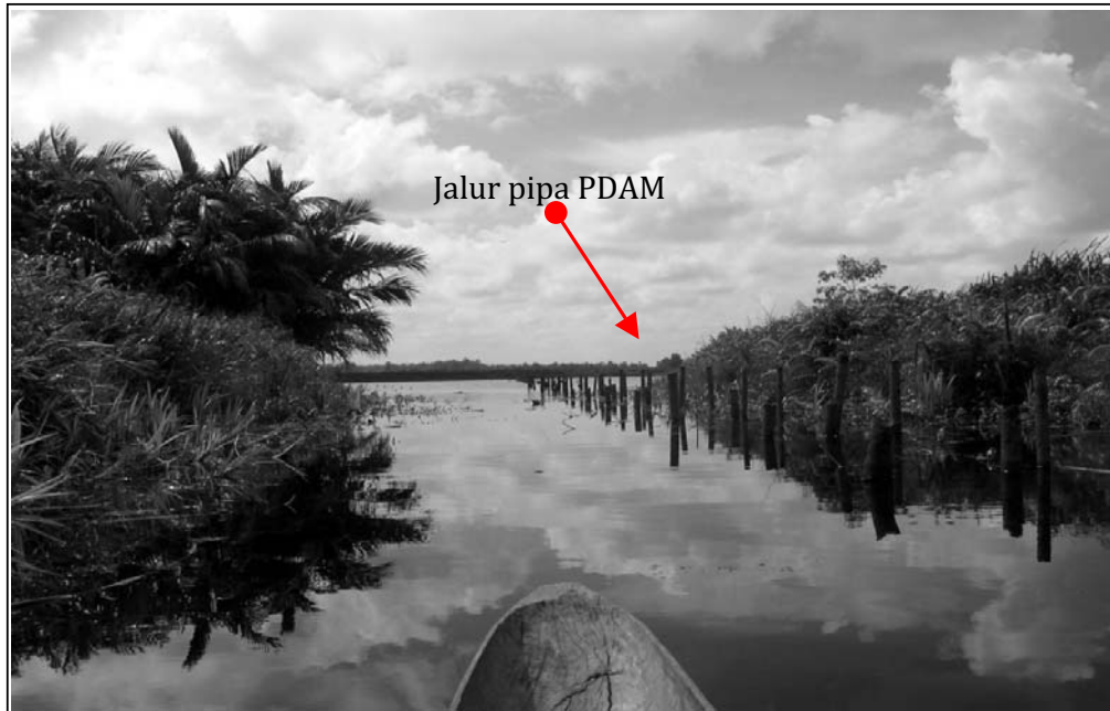
Gambar 3.4. DAS Rawa Biru. Tiang-tiang yang dipasang berjajar merupakan tanda bagi jalur pipa PDAM (doc WWF 2003)
