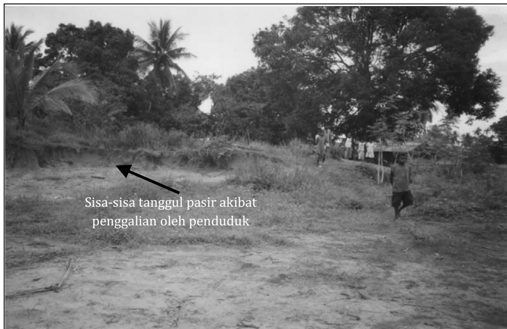
Gambar 7.2. Sisa tanggul pengamanan pantai yang telah digali untuk dimanfaatkan pasirnya ( dok. Dinas PDLPE, 2006 )
